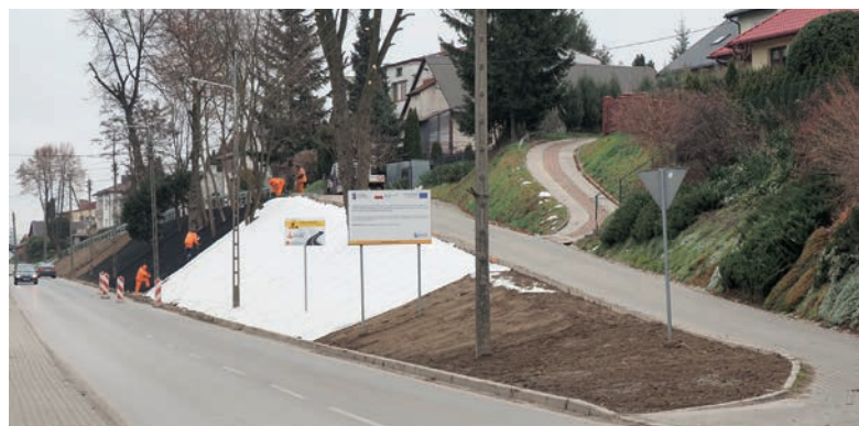
Prace przy zagospodarowaniu skarpy
