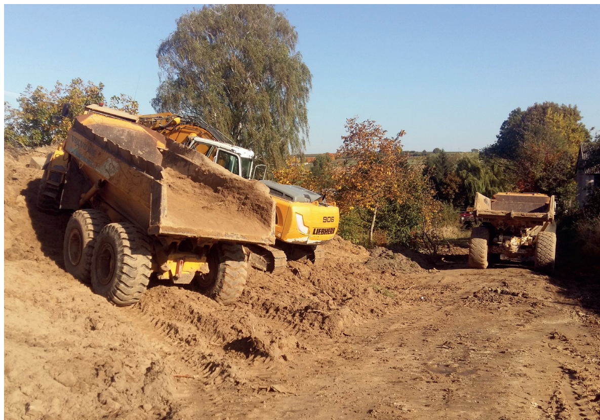
Prace budowlane przy drodze w Skorczycach
