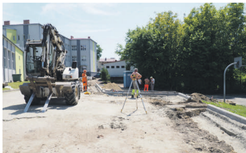
JC Prace przy poprawie układu komunikacyjnego przy ZSO w Urzędowie.
