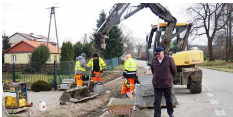
Budowa najdłuższego odcinka tego chodnika jest już na finiszu.
