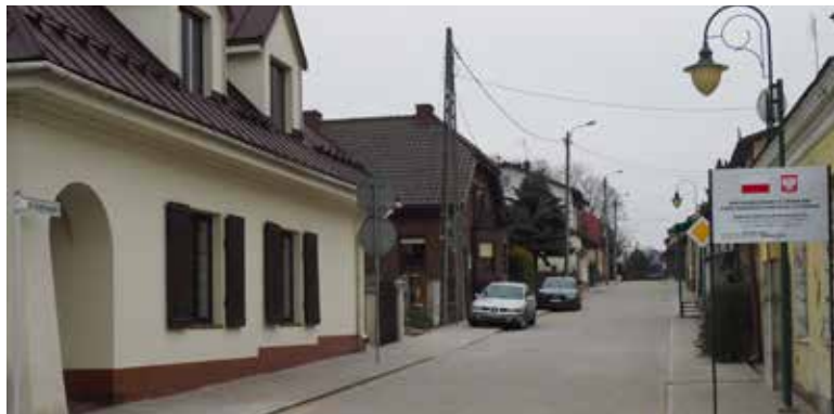
Przy udziale środków z FDS przebudowano ul. Kościuszki w centrum Urzędowa.
