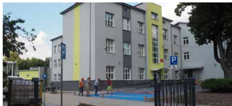
W ramach dwóch dofinansowań zmodernizowano urzędowską szkołę.
