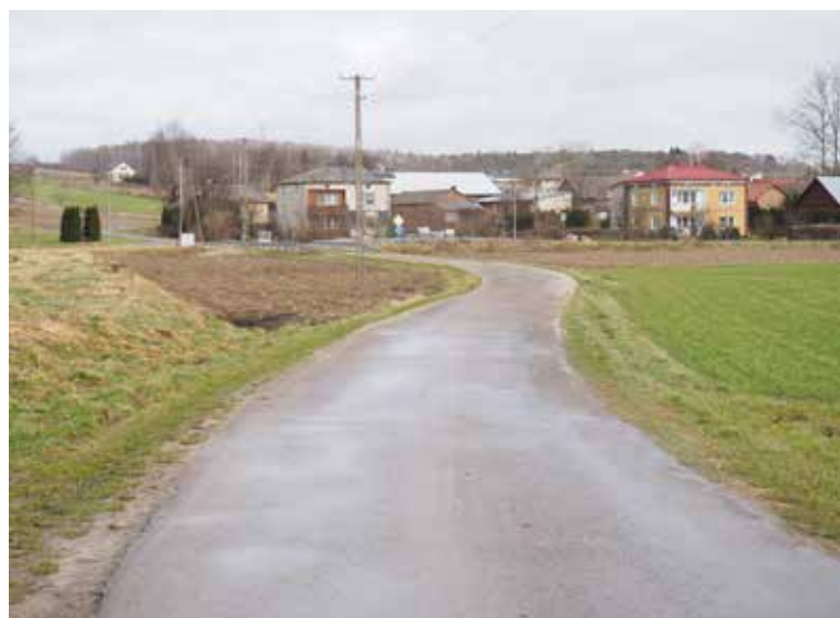
Droga w Moniakach przed remontem.
