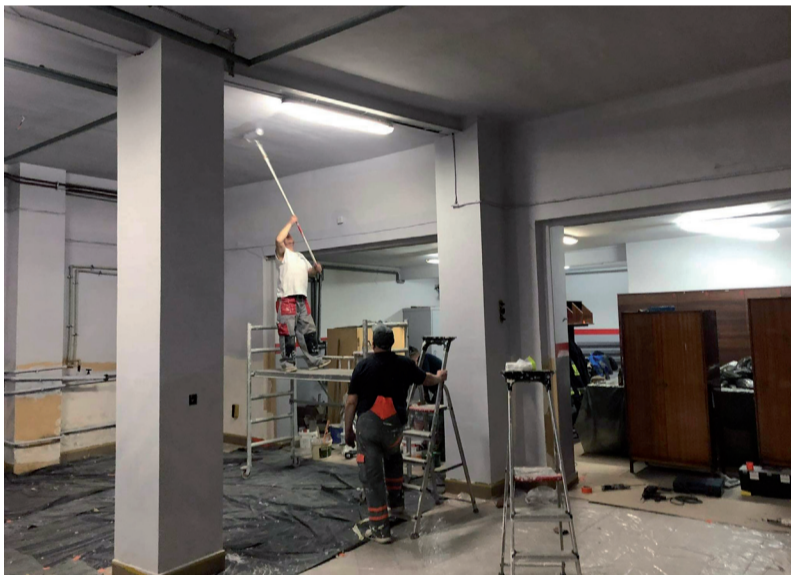
Strażacy z Urzędowa podczas remontu części garażowej swojej strażnicy.
