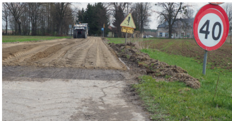
Ruszyły prace na drodze w Kolonii Wierzbicy.
