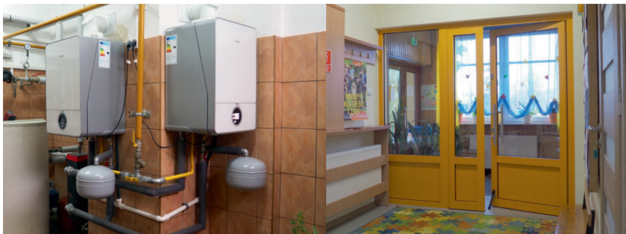
Ciepło w przedszkolu zapewniają teraz dwa nowe piece, a dzięki nowym drzwiom korytarz jest lepiej doświetlony.
