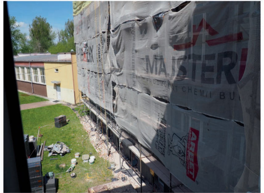
Prace rozpoczęły się od docieplenia ścian.
