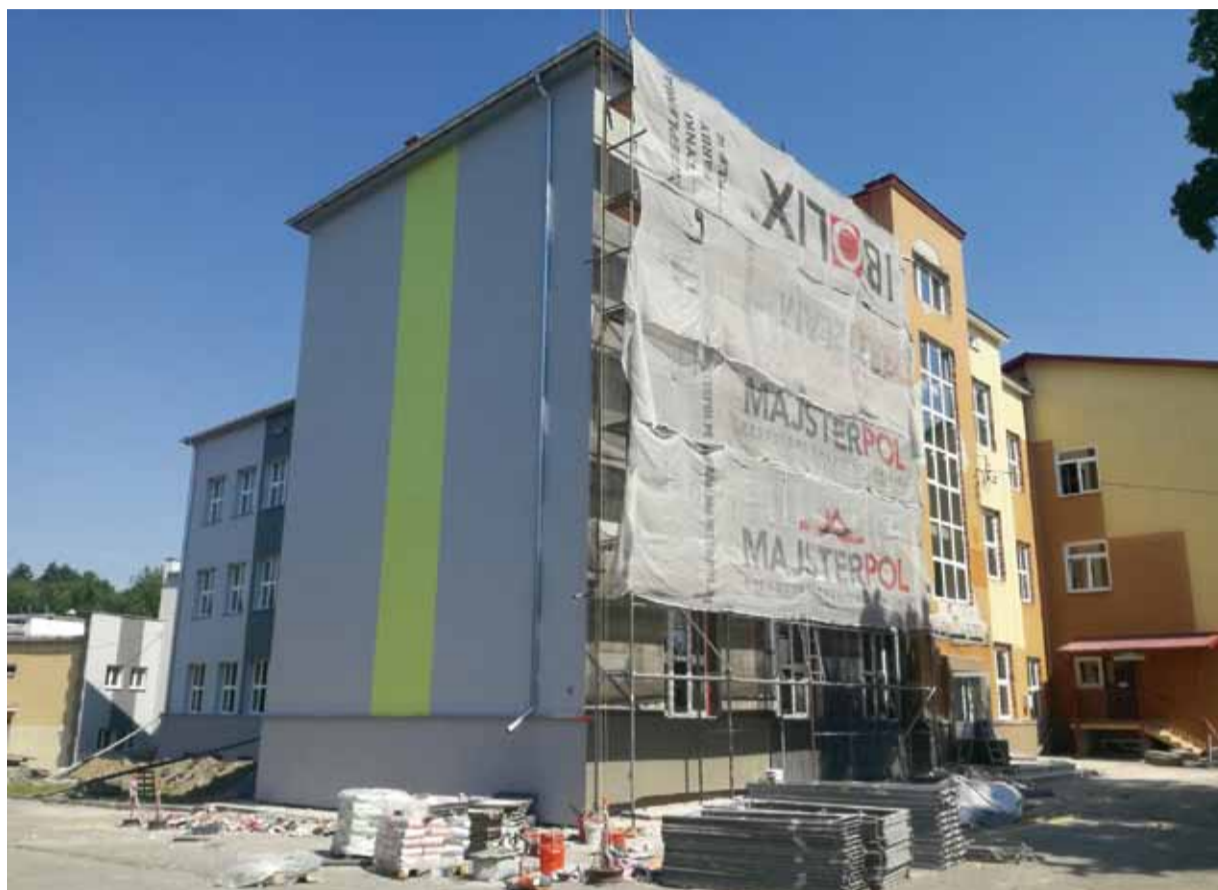
Aktualnie trwają roboty na froncie szkoły.
