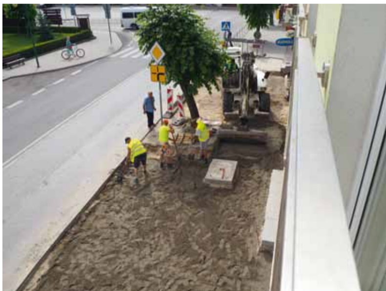
Ostatecznie zakończono wymianę chodnika w centrum Urzędowa.
