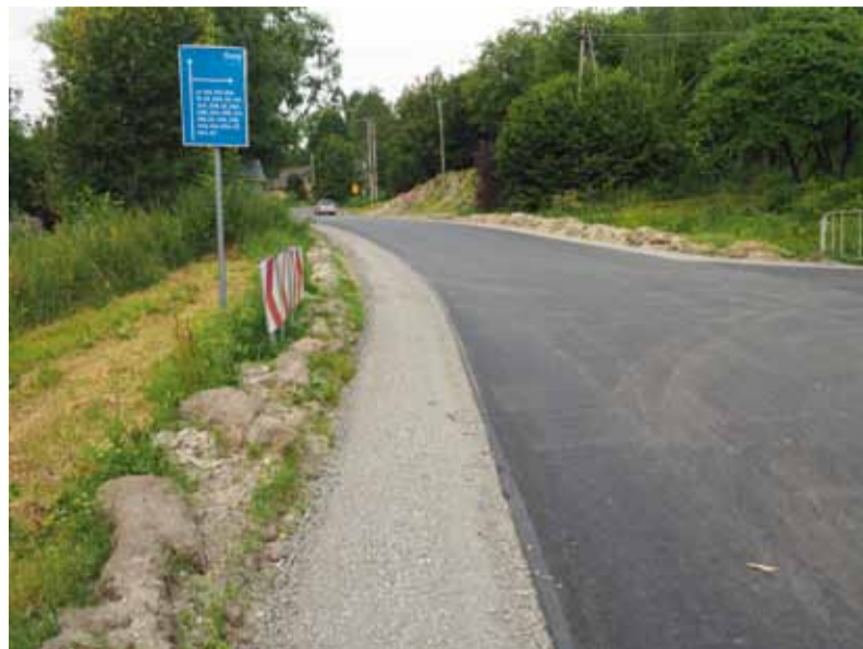
Mieszkańcy sołectwa Góry już korzystają z odnowionej drogi.
