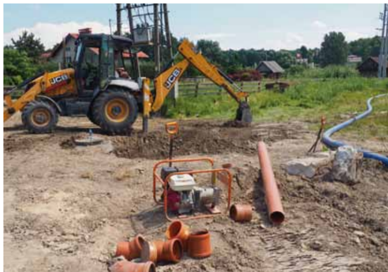
Prace przy budowie kanalizacji prowadzone były latem.
