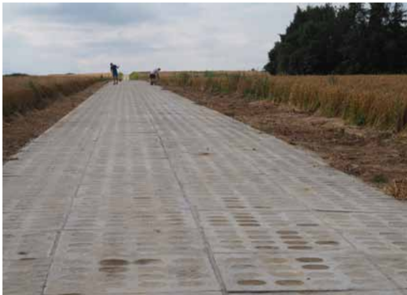
Droga dojazdowa do pól w Zakościelnym.
