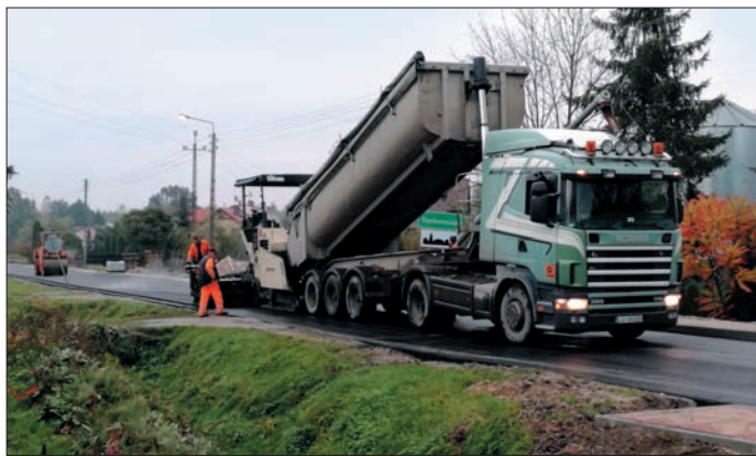
Roboty modernizacyjne na drodze gminnej w Rankowskim
