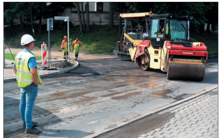
Końcowe prace przy przebudowie ulicy Podwalnej
