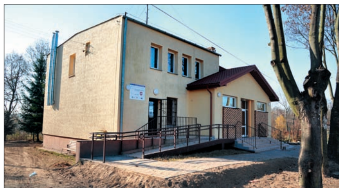
Budynek Ośrodka Zdrowia w Moniakach po rozbudowie
