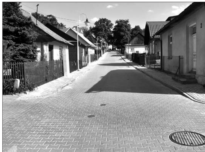
Ul. Janowska po przebudowie
