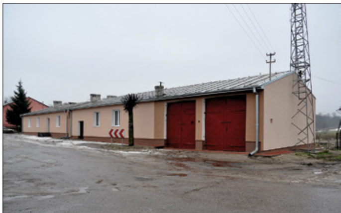
Remiza OSP Skorczyce po remoncie
