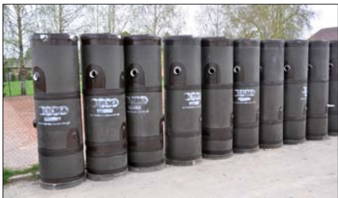
Przydomowe przepompownie przygotowane do instalacji
