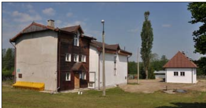
Budynek oczyszczalni ścieków, w głębi po prawej – budynek sitopiaskownika
