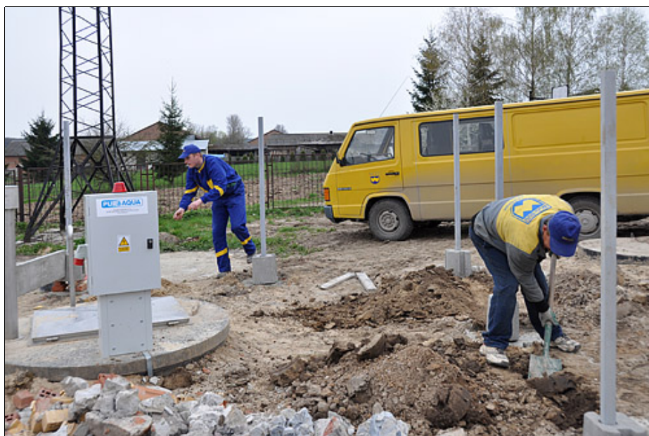
Budowa sieci sanitarnej w Bęczynie
