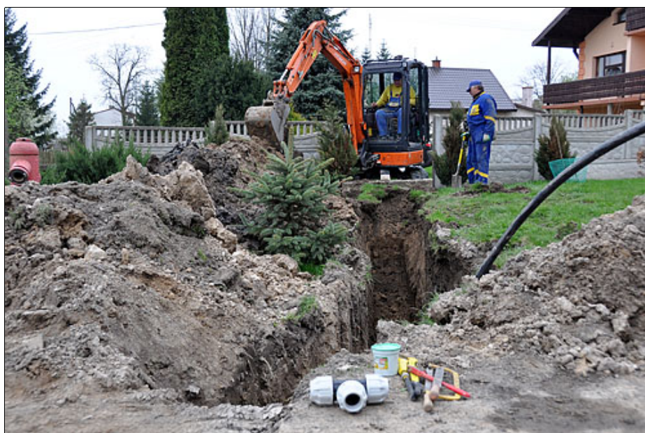
Prace przy przepompowni sieciowej ścieków w Bęczynie
