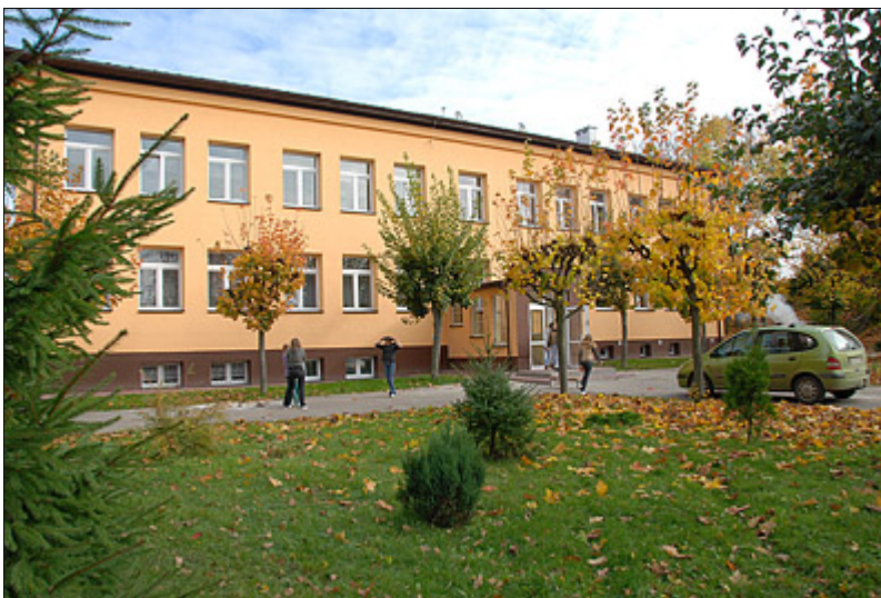
Szkoła w Leszczynie po termomodernizacji
