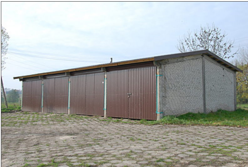
Wyremontowane garaże w Skorczycach
