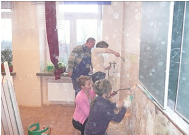
Prace przy usuwaniu starej lamperii były bardzo uciążliwe
