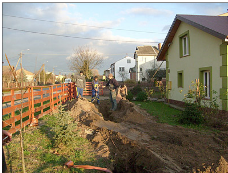
Roboty montażowe sieci kanalizacyjnej
