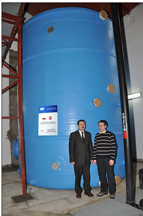
Nowo zainstalowany zbiornik reaktora
