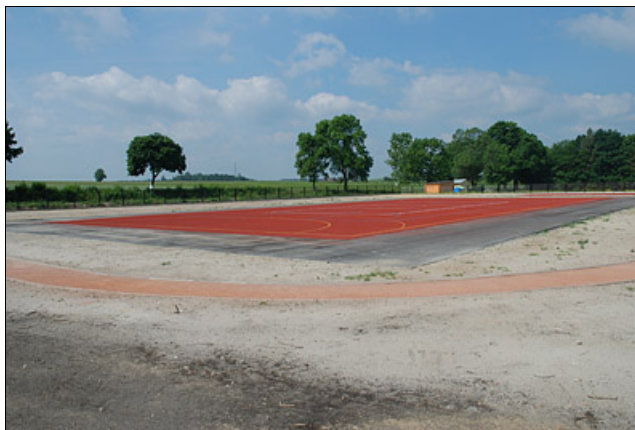
Boisko w Skorzcycach w trakcie budowy
