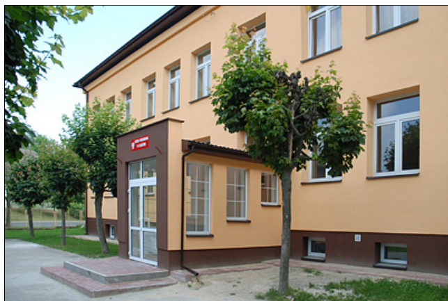
Budynek Szkoły Podstawowej po termomodernizacji
