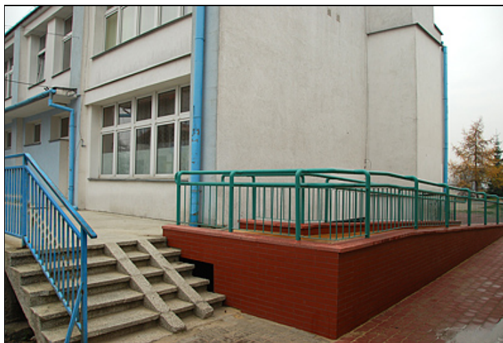
Podjazd dla osób niepełnosprawnych przy Ośrodku Zdrowia w Urzędowie.
