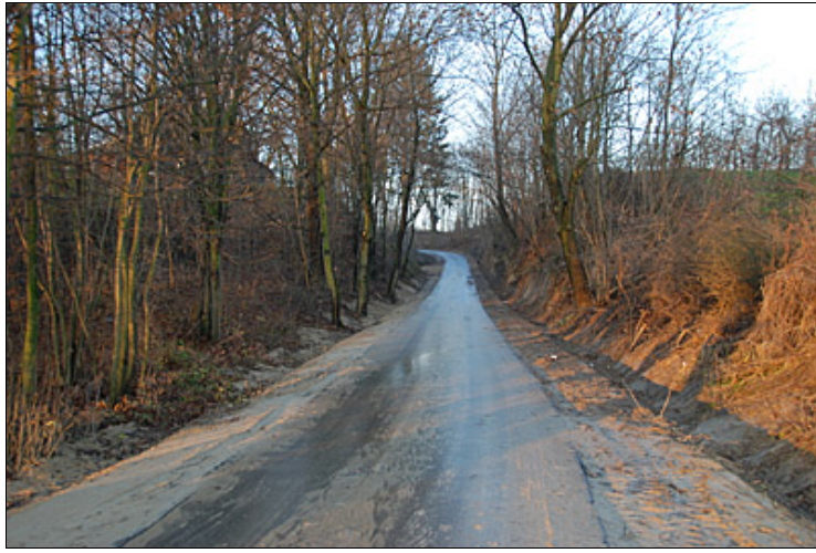
Przebudowana nawierzchnia drogi w Metelinie
