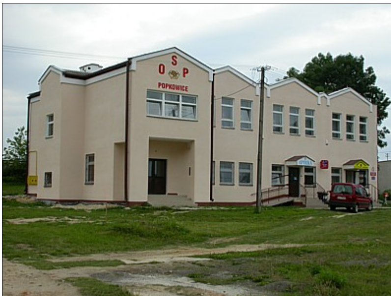
Budynek wielofunkcyjny w Popkowicach po wykonaniu elewacji
