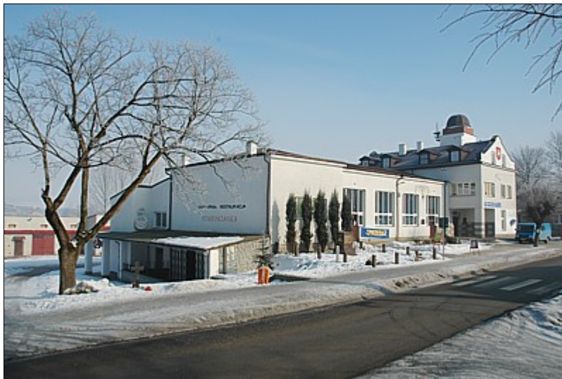
Gminny Ośrodek Kultury po nadbudowie i modernizacji
