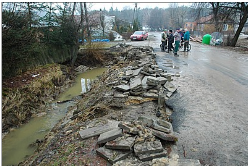
Zniszczone chodniki w Bęczynie
