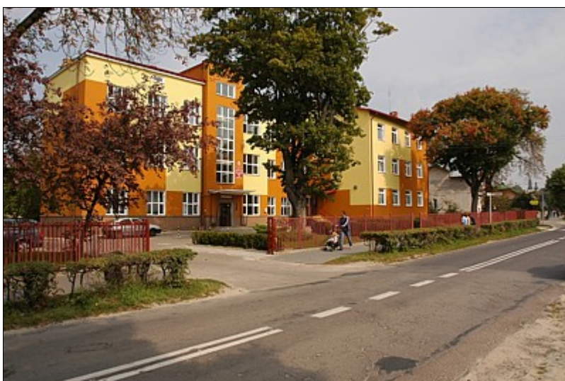
Rozbudowany budynek ZSO w Urzędowie
