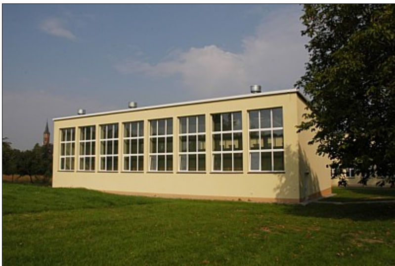
Budowa sali gimnastycznej w Szkole Podstawowej w Bobach Kolonii.
