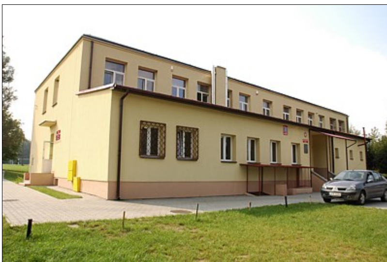
Termomodernizacja i gruntowny remont budynku Szkoły Podstawowej W Bobach Kolonii.
