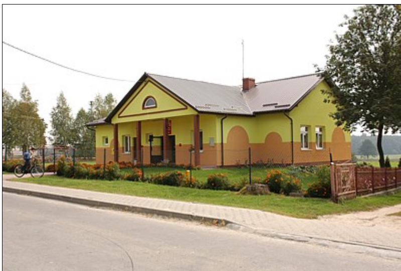
Budowa nowej Szkoły Podstawowej kl. I - IV w Bęczynie.
