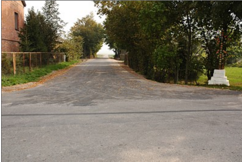
Zmodernizowana droga Zadworze - Józefin
