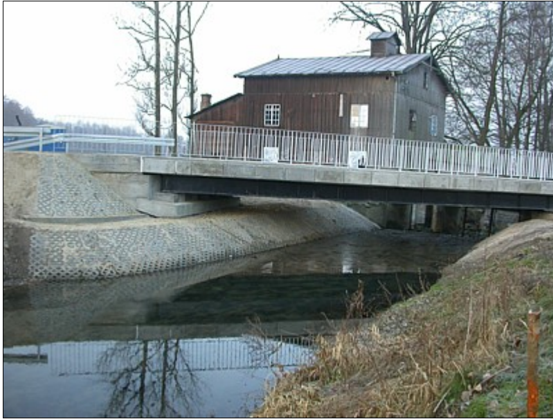
Most na rzece Urzędówce po odbudowie
