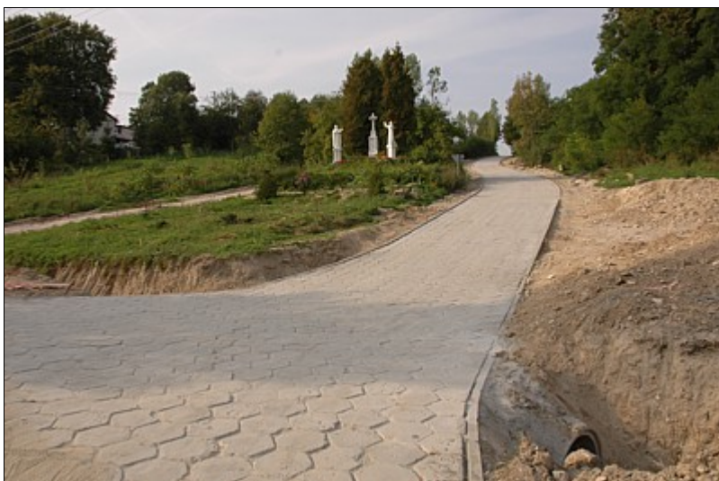
Zmodernizowany odcinek drogi w sołectwie Góry
