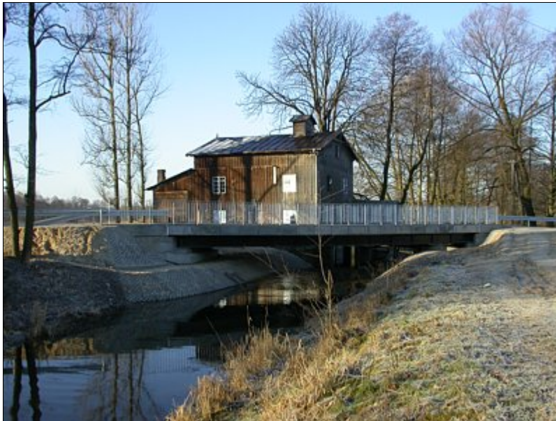
Odbudowany most na rzece Urzędówce
