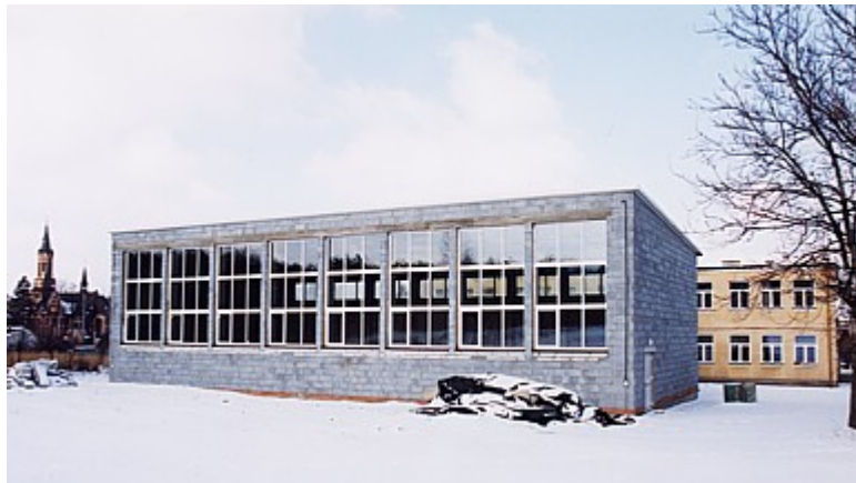
Sala w budowie - stan aktualny
