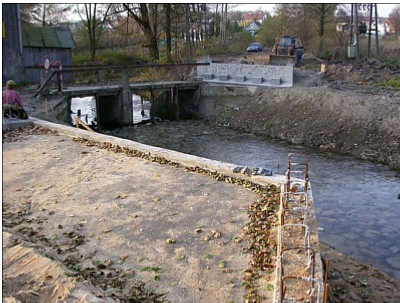
Odbudowa mostu na rzece Urzędówce w trakcie realizacji
