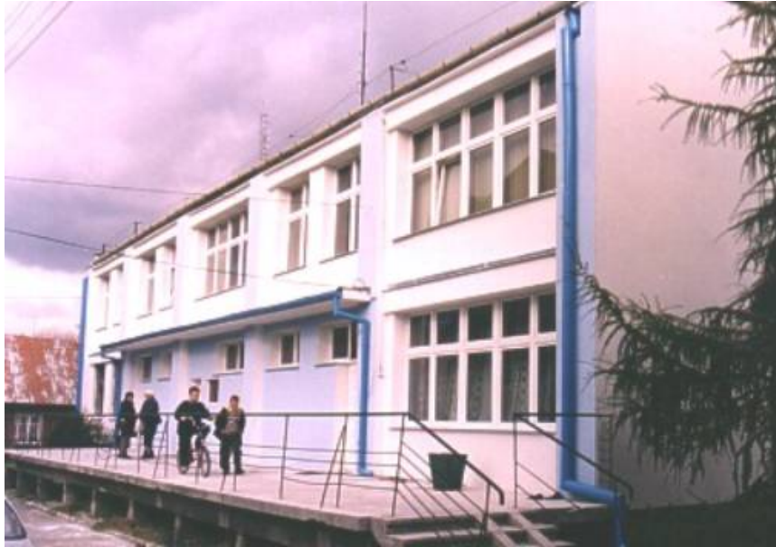
Wyremontowany budynek Ośrodka Zdrowia
