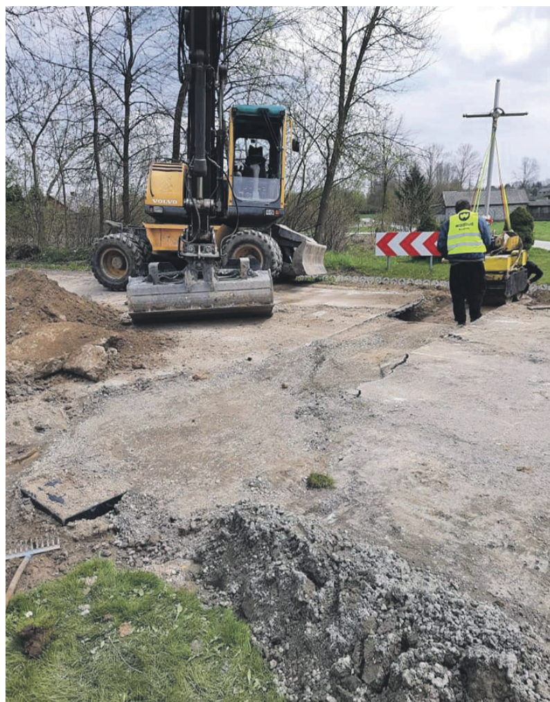
Prace przy przebudowie przepustu.
