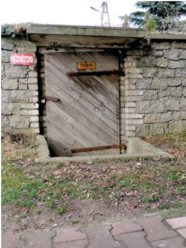
Wejście do lodowni
