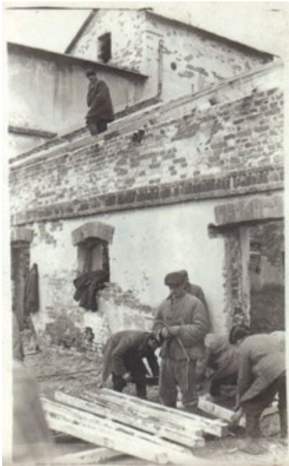
Prace przy rozbiórce browaru
