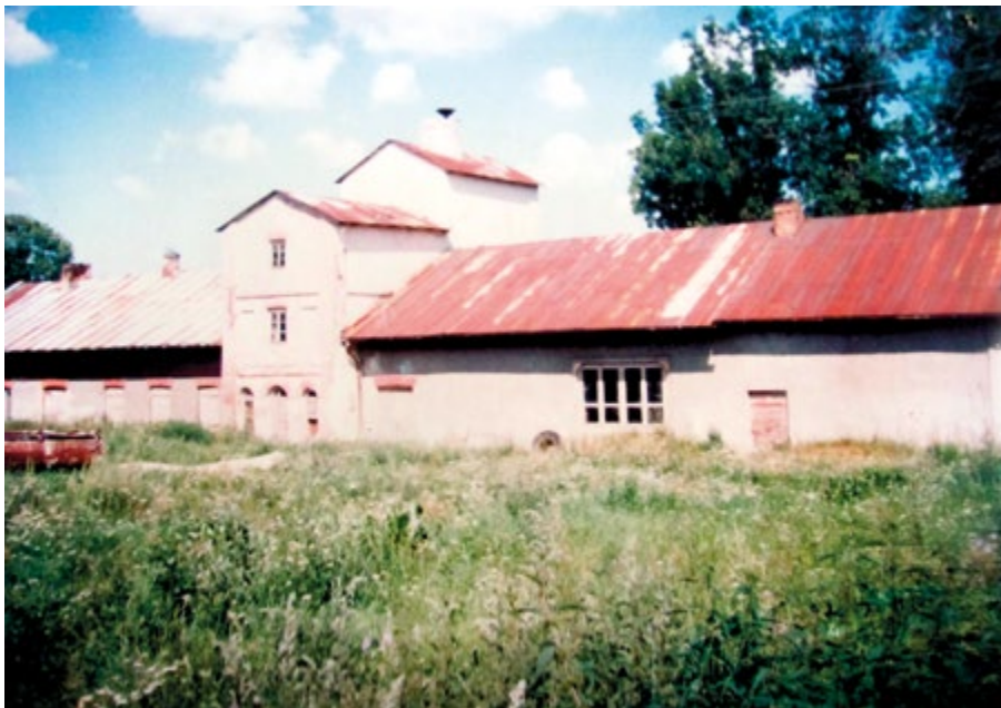
Browar po zamknięciu, widok od strony dziedzińca
