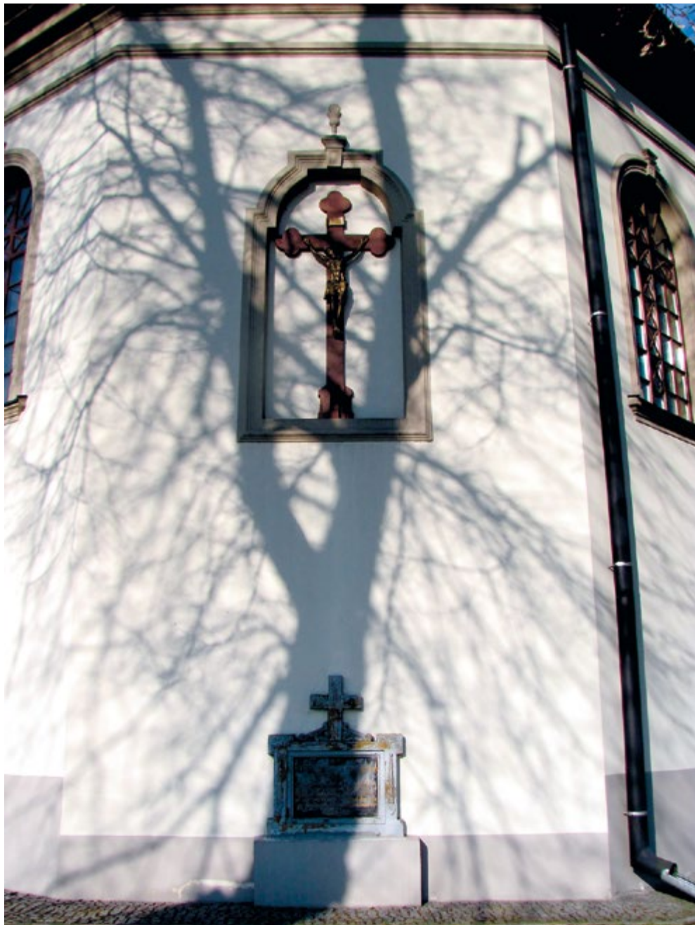
Kościół w Popkowicach od strony wschodniej z tablicą Eleonory Piaseckiej na ścianie świątyni
