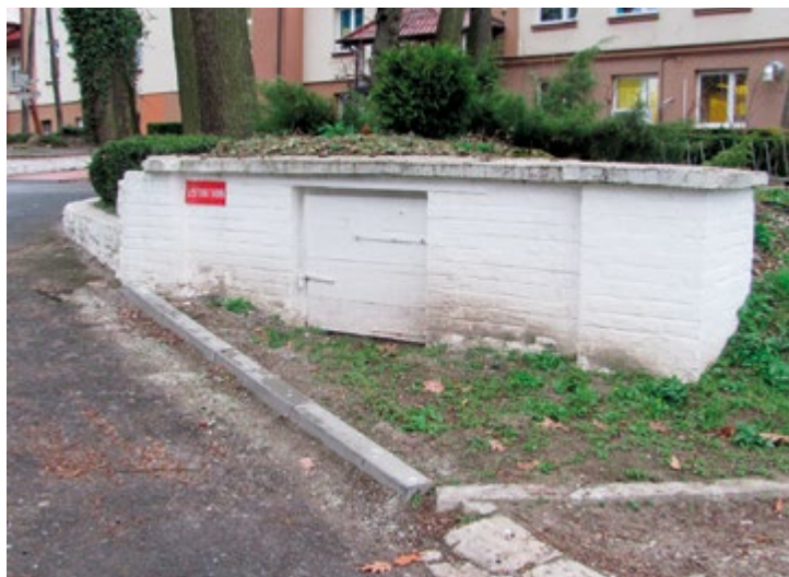
Piwnica – pozostałość po starym dworze
